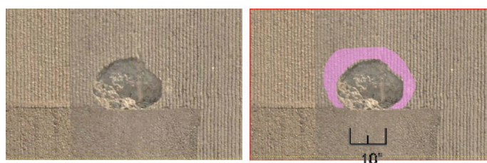
図 3-6 ポットホールとその周辺 のうき (Stage III) 左：高解像度可視画像、右： ひび割れ と うき の範囲の表示。
